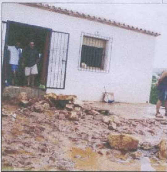
La avalancha de agua provocó daños en varias viviendas.
